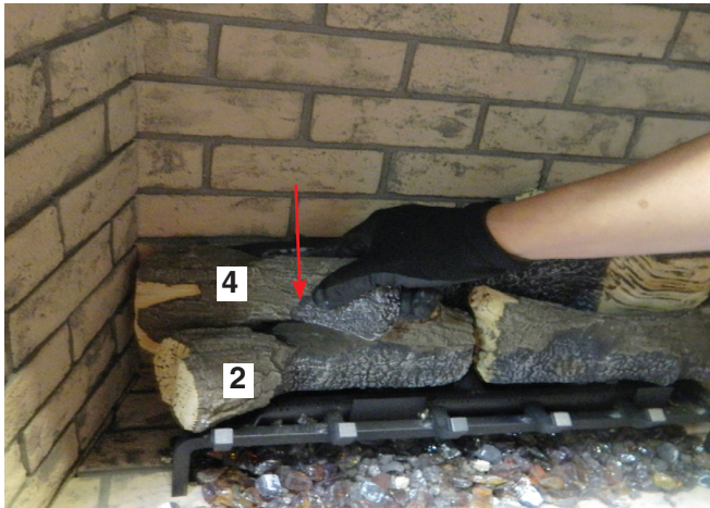
Diagram 11—Install Log 4
